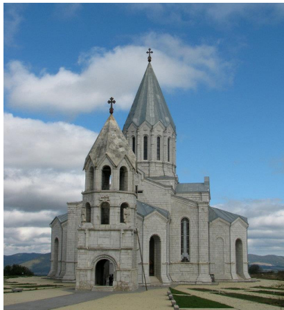
Շուշիի Ղազանչեցոց Սուրբ Ամենափրկիչ եկեղեցին
